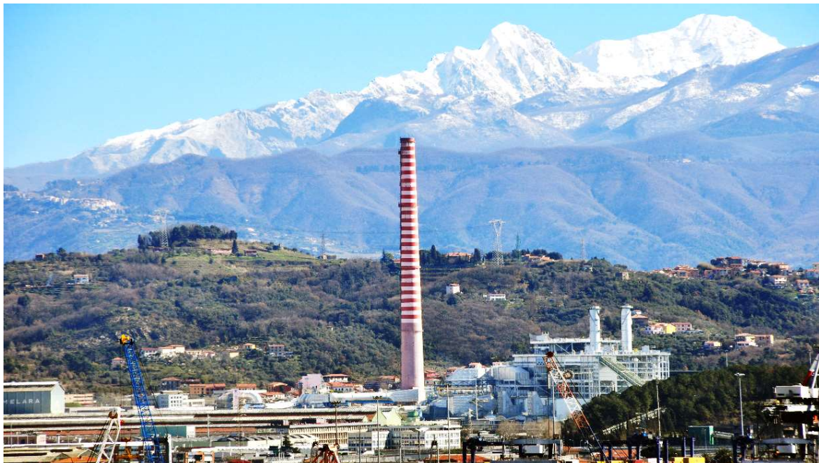
Vista panoramica della centrale termoelettrica Enel di La Spezia
