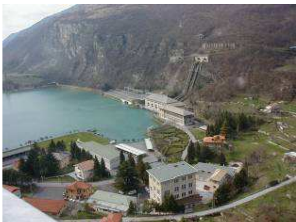
Centrale di Nove 25 e Nove 71
