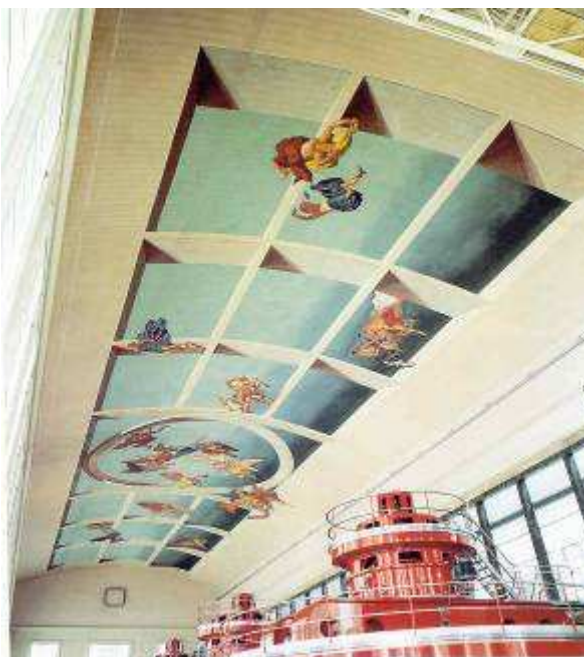
Centrale di Soverzene – soffitto interno sala quadri
